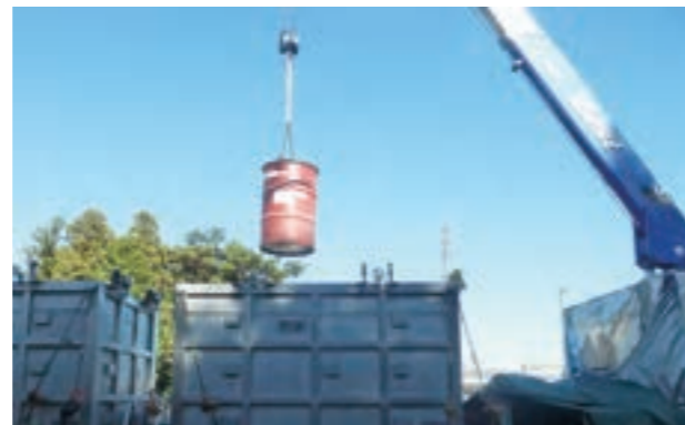
PCB廃棄物搬出の様子
