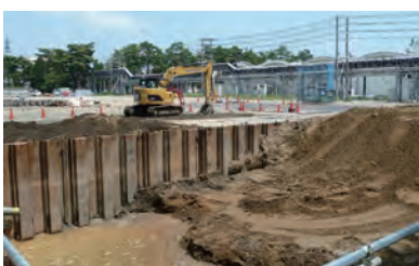
汚染土壌の掘削作業の様子
