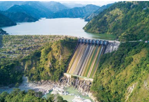
水力発電所全景
